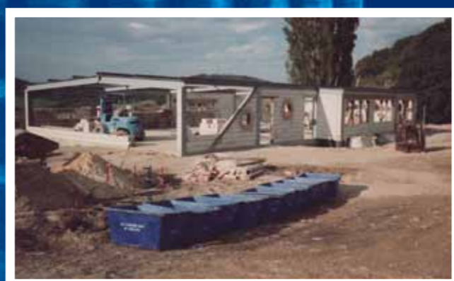
Stahlkonstruktion für Betriebs- und Werkstatt- gebäude, Deponie Großlöbichau
