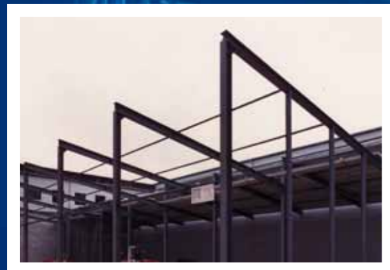
Stahlkonstruktion Halle Schott Jenaer Glas GmbH
