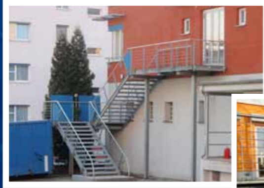
Zugangstreppe DRK-Seniorenheim, Jena
