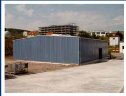
Neubau Lagerhalle Jena, Stahlkonstruktion mit Trapezblechverkleidung
